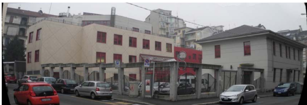
esempio di termogramma (sopra) e fotografia degli edifici oggetto di analisi
